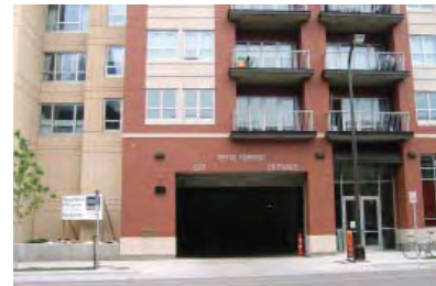
Garage door placement
