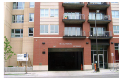
Garage door placement
